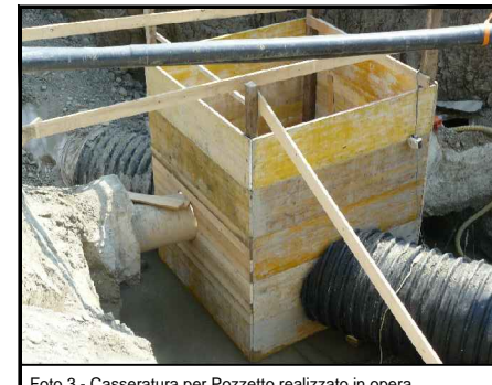
Foto 3 - Casseratura per Pozzetto realizzato in opera
