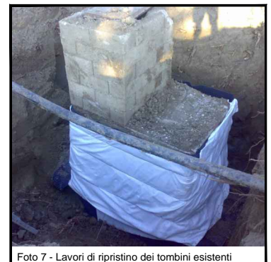
Foto 7 - Lavori di ripristino dei tombini esistenti
