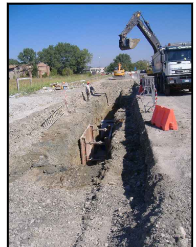
Foto 6 - Vista delle varie fasi di realizzazione del cantiere: scavo di sbancamento, scavo a sezione obbligatoria, posa armatura, posa della tubazione e del tombino
