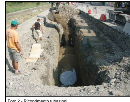
Foto 2 - Ricoprimento tubazioni
