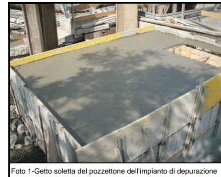
Foto 1 - Getto soletta del pozzetto dell'impianto di depurazione
