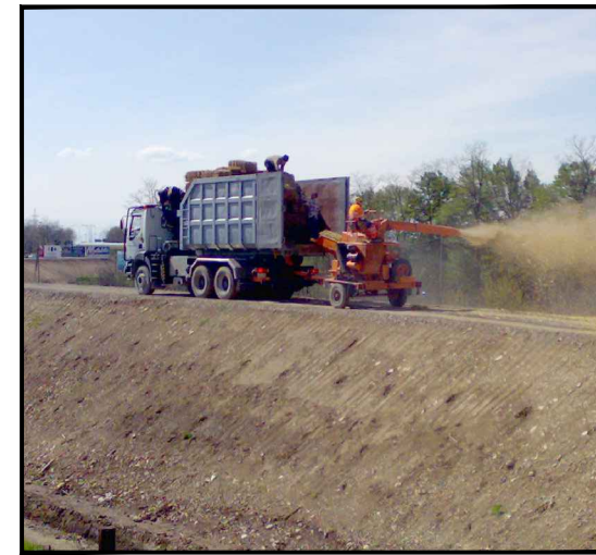
Foto 1 - Esecuzione di idrosemina a spessore
