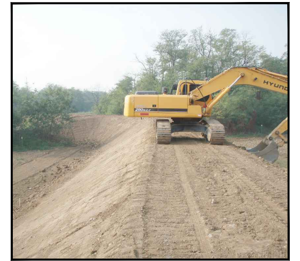
Foto 2 - Argine durante i lavori di realizzazione
