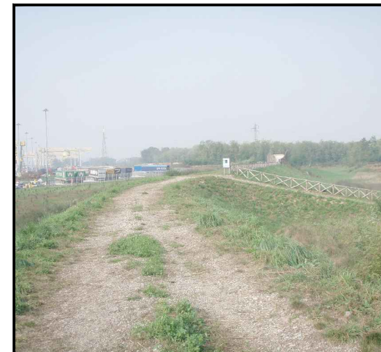
Foto 3 - Argine subito dopo l'inerbimento
