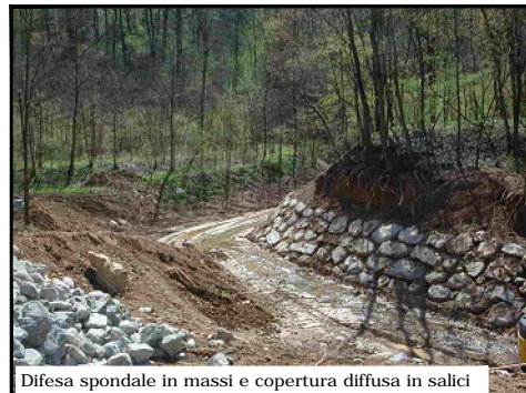
Difesa spondale in massi e copertura diffusa in salici
