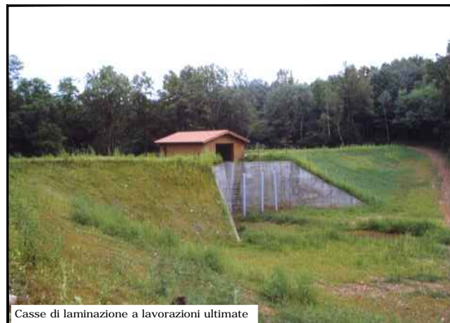
Casse di laminazione a lavorazioni ultimate
