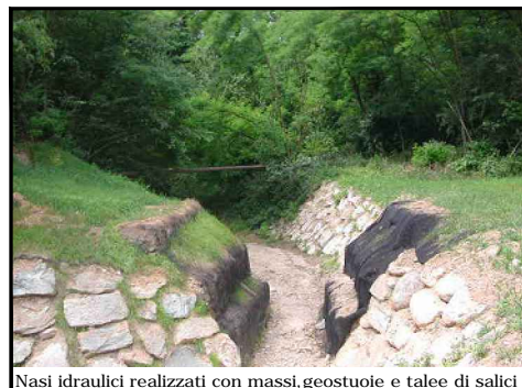
Nasi idraulici realizzati con massi, geostuoie e talle di salici
