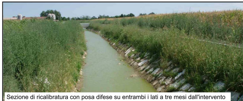
Sezione di ricalibratura con posa difese su entrambi i lati a tre mesi dall'intervento
